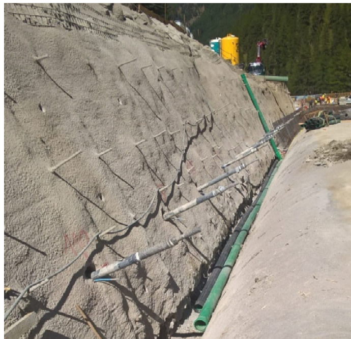
Bild 8: Verpressanker
