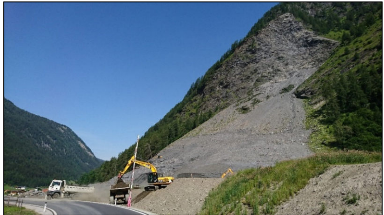
Abbildung 1: Bauarbeiten im Juni 2020
