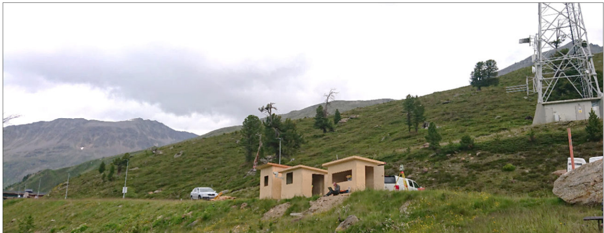
Abbildung 1: Die Messhütten nahe der Mautstation Timmelsjoch. Temporäre Messhütte für TLS (links), neue Messhütte für TLS sowie Stromversorgung für Webcam und InSAR (mitte), InSAR mit Schutzhütte (rechts).
