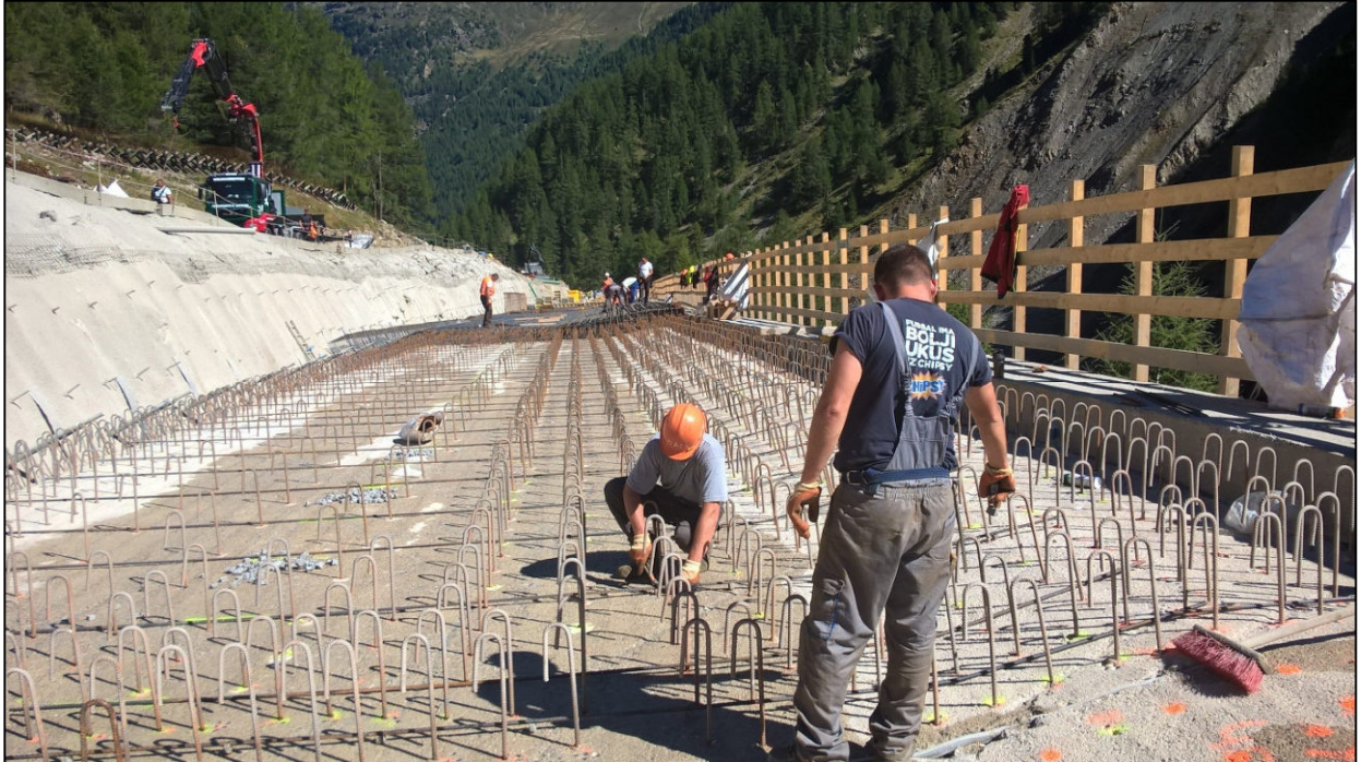
Bild 9: Schubverdübelung
